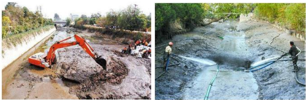
图3-3 机械清淤图示（左）、人工清淤（右）
