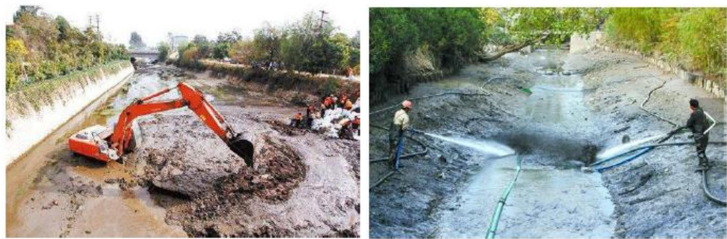
图3-3 机械清淤图示（左）、人工清淤（右）
