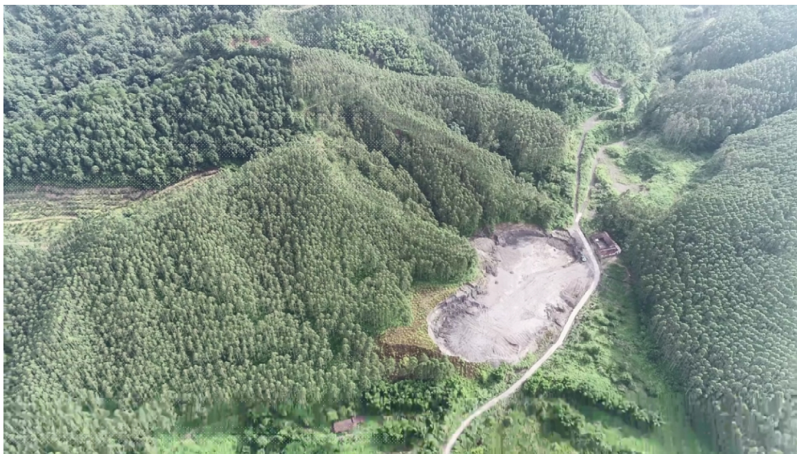
图 3-7 部分破坏土地资源现场照片
