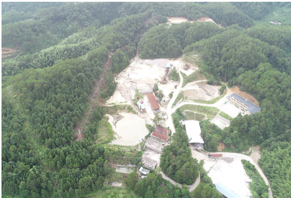
图 3-6 生产建设活动现场照片
