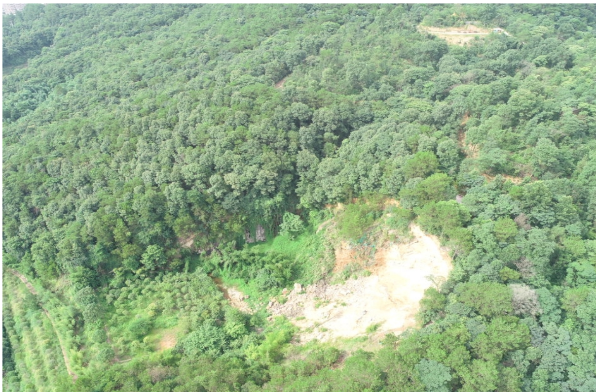
图 3-3 仁化县自然侵蚀-崩岗现场照片
