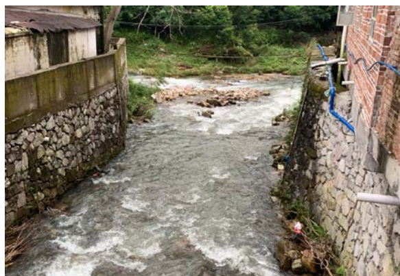
长珠坑水堤防
