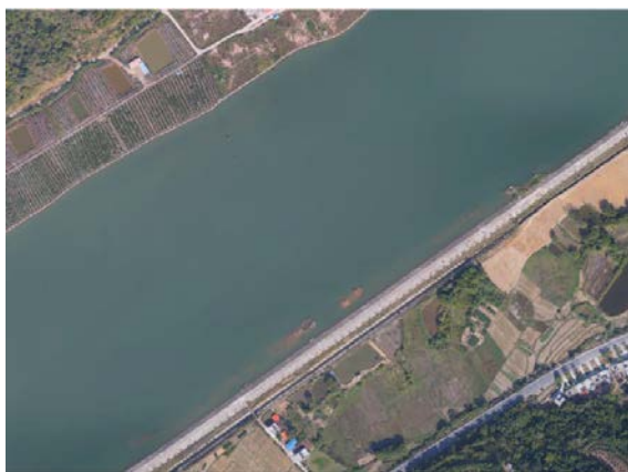
大桥段左岸堤防
