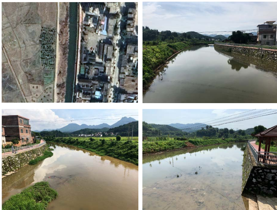
图 3-8 扶溪水堤防现状情况
