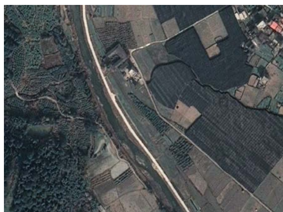
陈欧河左岸堤防
