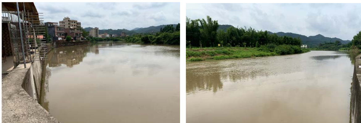
图 3-9 百顺水堤防现状情况
