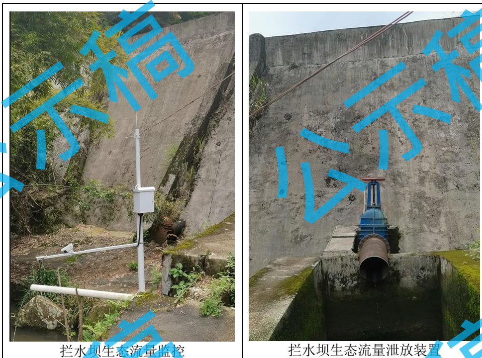
图 5-1 前洞电站最小生态下泄流量现场照片
