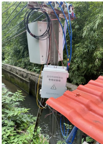
图 5-1 石塘镇芦头水一级电站最小生态下泄流量现场照片
